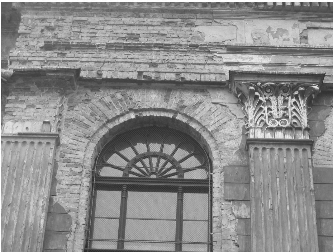
Il. 28. Widok na stolarkę okienną synagogi pod Białym Bocianem we Wrocławiu.
