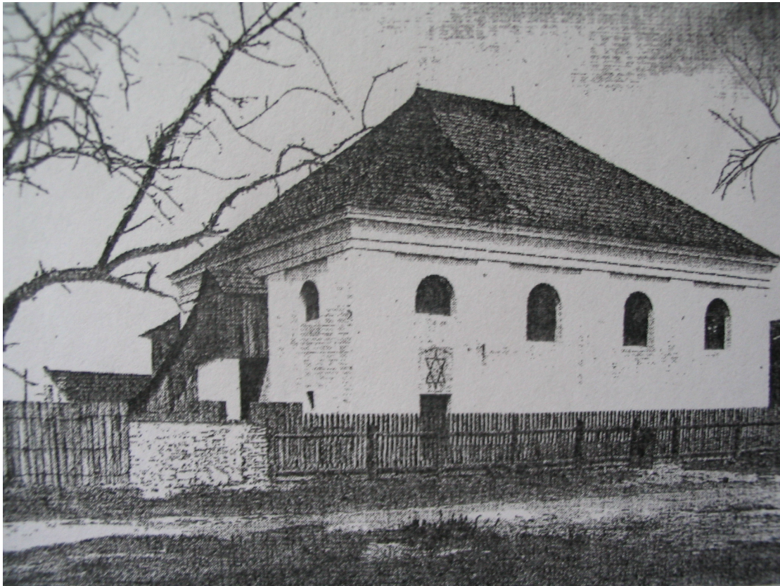
II.22. Synagoga w Szczekocinach - widok od południowego zachodu, stan przed 1939 roku
